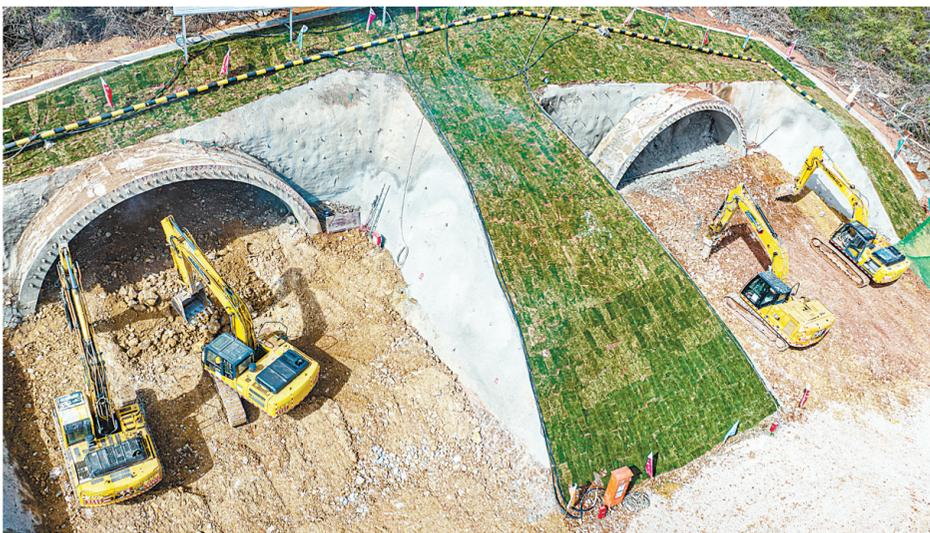
3月19日,襄阳至宜昌高速公路宜昌段长坂坡特长隧道进口处,挖掘机开始进洞作业。该隧道全长8365米,施工难度大,其进洞施工为项目全面展开施工奠定了基础。
