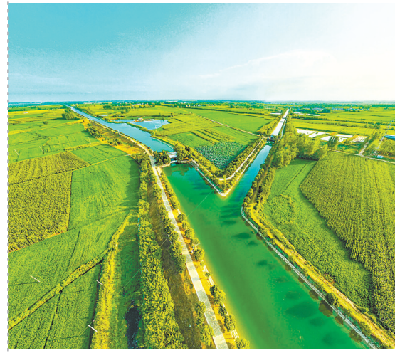
老河口清江丹渠水源不断向当地灌区输送。（湖北日报全媒体记者 田悦 通讯员 谢勇 李雯艳 摄）
