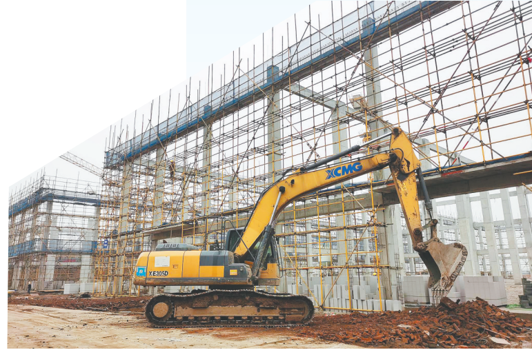
荆州经开区内湖北先导电子信息产业园正在加紧施工。
