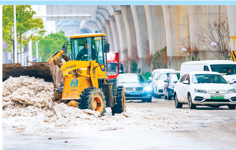
2月23日,武汉市洪山区烽胜路,几台工程机械在奋力铲除路上积存的冰雪。
