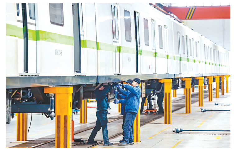
2月19日,在武汉地铁4号线青山车辆段联合检修库内,工人正对行驶里程达到120万公里的3列列车开展大修作业。(湖北日报全媒体记者 倪娜 通讯员 李丹 产启斗 摄)
