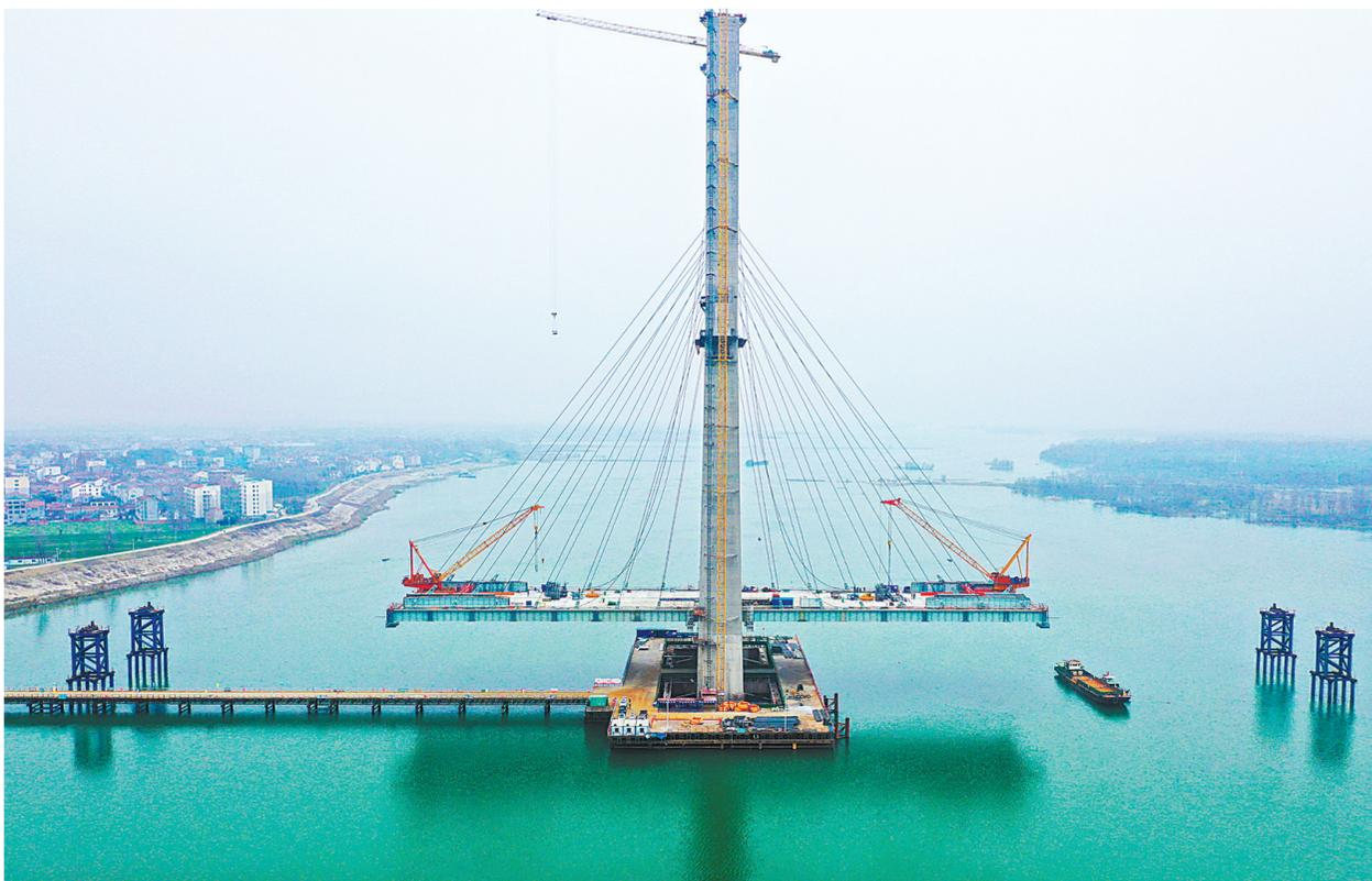
2月18日，中交二航局工人在襄阳牛首汉江特大桥进行吊装作业。该桥是207国道襄阳段改建工程全线重难点控制性工程，主塔高201米，是汉江最高的桥塔，建成后将是国内最大跨径组合梁独塔斜拉桥。（湖北日报全媒体记者 田悦 通讯员 张飞 张沛 摄）
