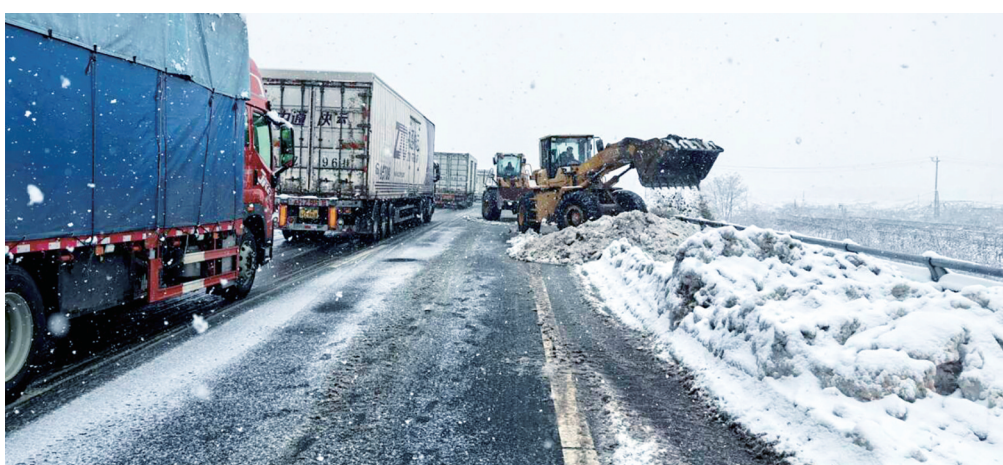
湖北交投建设集团紧急打通京港澳高速堵点。
