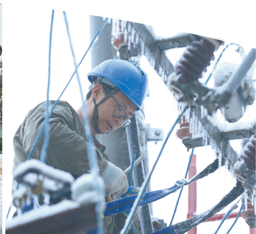
国网武汉供电公司员工对覆冰供电线路和设备进行除冰抢修。
