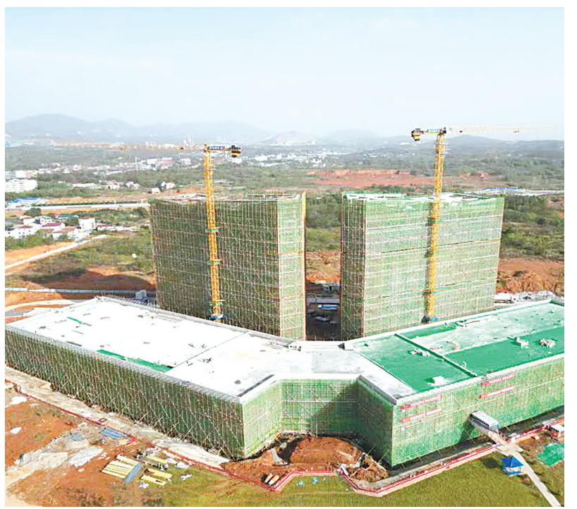
建设中的科创中心。（黄石临空经济区·还地桥镇供图）
