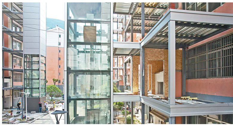
兴山县县城老旧小区改造二期项目兴发家园电梯加装工程项目现场。“旧改+增梯”“一键直达”让居民不再有爬楼梯的困扰。(湖北日报全媒记者 刘耀松 通讯员 乔长娇 摄)
