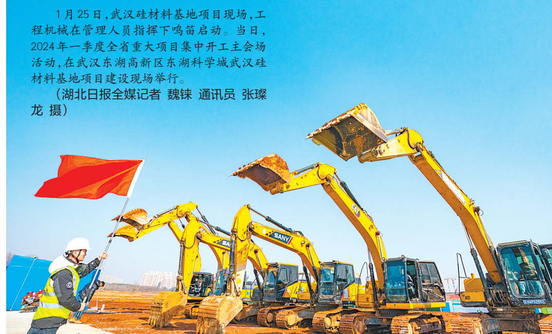
1月25日,武汉硅材料基地项目现场,工程机械在管理人员指挥下鸣笛启动。当日,2024年一季度全省重大项目集中开工主会场活动,在武汉东湖高新区东湖科学城武汉硅材料基地项目建设现场举行。(湖北日报全媒体记者 魏臻 通讯员 张琛 龙摄)
