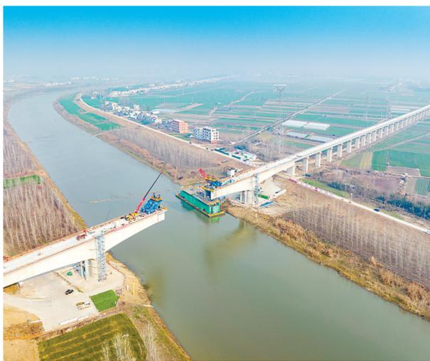
1月10日，沪渝蓉高铁武宜段天门汉北河特大桥钢混连续梁建设现场，工人正在加紧施工。汉北河特大桥横跨天门九真镇和石家河镇，全长6188.49米，是沿江高铁天门段控制性工程之一。大桥建设引入钢箱梁技术，实现了超长跨越，缩短了建设周期。目前，工程建设正在紧张有序施工，冲刺月底吊装实现大桥合龙。
