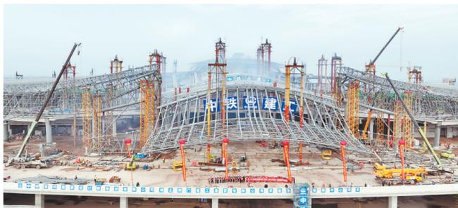
1月6日17时许,沪渝蓉高速铁路武宜段荆门西站站房最后一块钢结构网架提升成功,标志着荆门西站站房工程正式转入金属屋面施工和装饰装修阶段。(视界网 朱俊波 李瑞东 摄)
