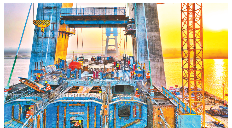
1月1日,在沪渝蓉高速铁路钟祥汉江特大桥,大桥建设者们坚守岗位,加班加点抢工期,全力确保施工进度。钟祥汉江特大桥是沪渝蓉沿江高铁武汉至宜昌段关键性控制性工程之一,全长547.5米,主跨270米,是世界最大跨度高速铁路混凝土梁斜拉桥。(视界网 钟国庆 摄)
