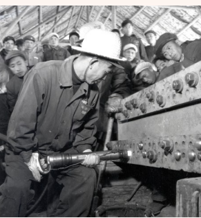
武汉长江大桥建设期间,工人使用铆钉风枪进行铆钉铆合和钢梁拼接,直至铆钉完全填满眼孔。
