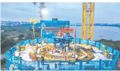
世界首座不同垂度四主缆钢桁梁悬索桥——燕矶长江大桥建设现场。
