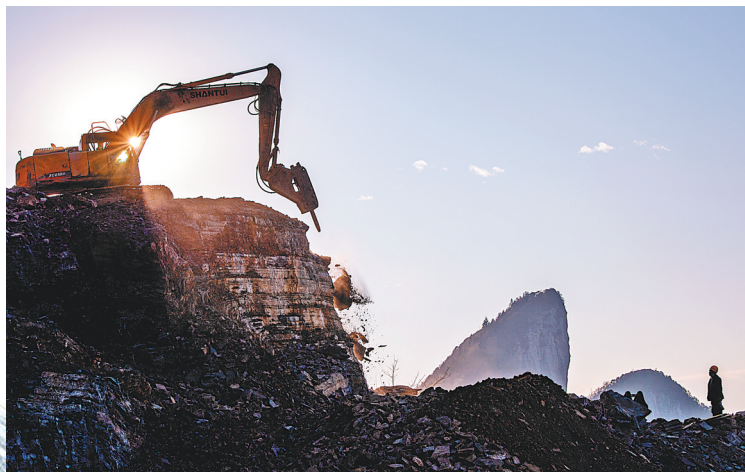
12月9日，见天村鸡公岭山顶上，挖掘机师傅在绝壁上施工。
