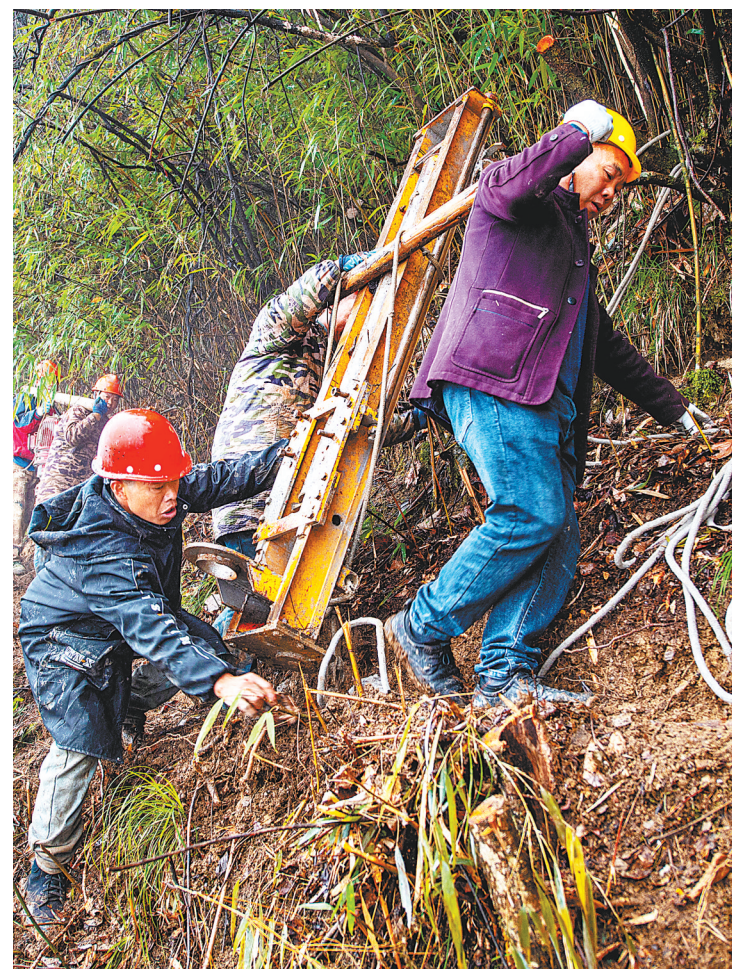
12月11日，见天村党支部副书记张应轩（右一）与施工人员抬着机械设备上鸡公岭。
