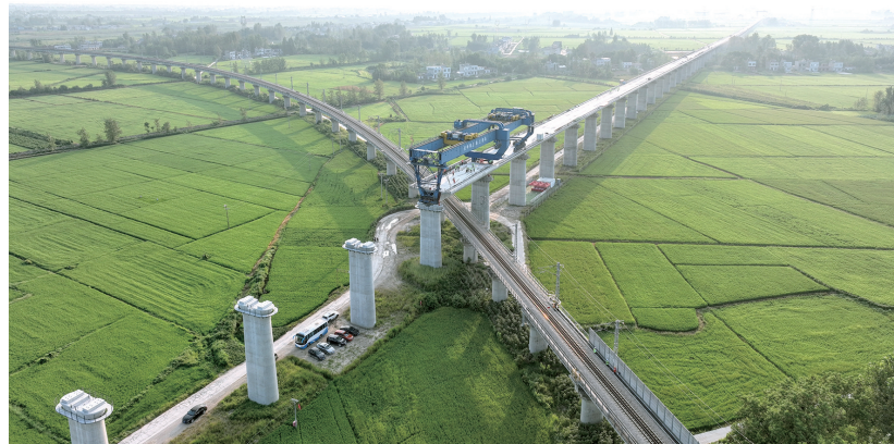
建设中的沿江高铁。
