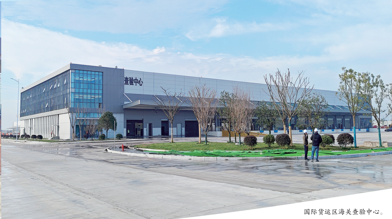
花湖机场国际货运区主体建筑竣工。
