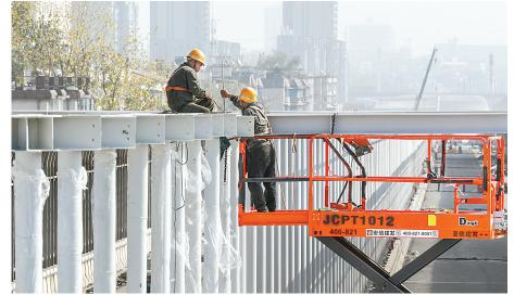
11月28日,在武汉友谊大道快速化改造北段工程四标段施工现场,工人站在升降车上进行声屏障附属设施安装作业。
