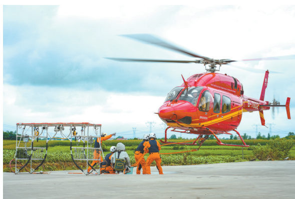
国网湖北电力员工开展特高压线路直升机吊篮法带电作业。
